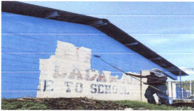
FOTO 7: Pintando muro exterior 28 de largo 2.5 de alto
