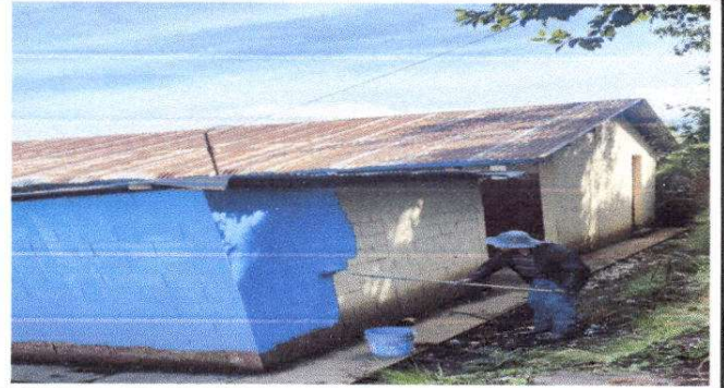
FOTO 8: Pintando bodega y muro exterior de escuela
