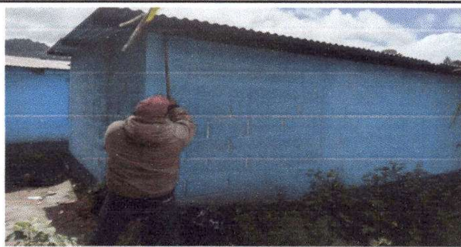
FOTO 11: Pintando exterior de la cocina
