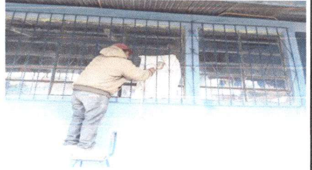
FOTO 10: Mantenimiento de barandas
